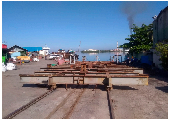
Figura 1. Cuna de Varado. Ensamble del conjunto de eje y pastecas.
